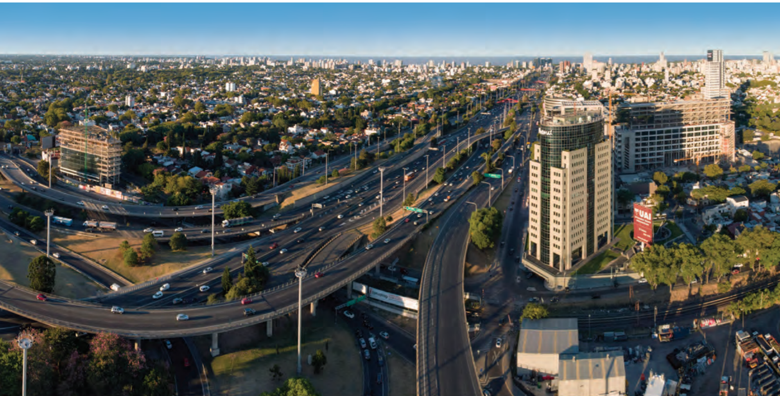
Autopistas del Sol. Argentina
