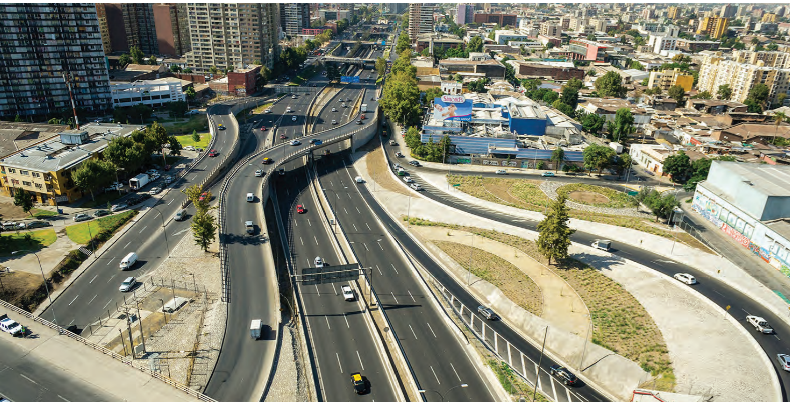
Víaschile. Autopista Central
