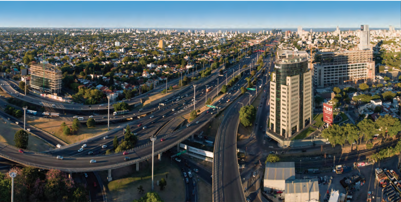
Autopistas del Sol. Argentina
