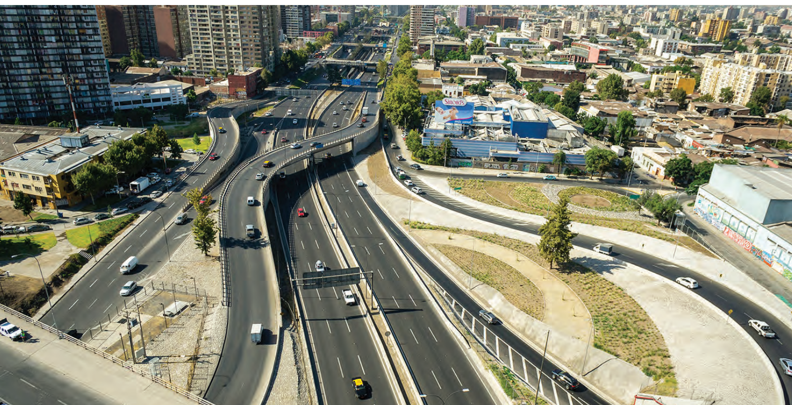
Víaschile. Autopista Central
