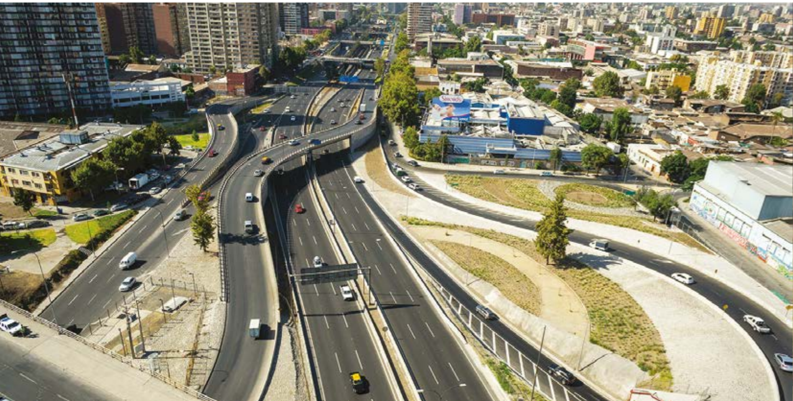
Viaschile. Autopista Central
