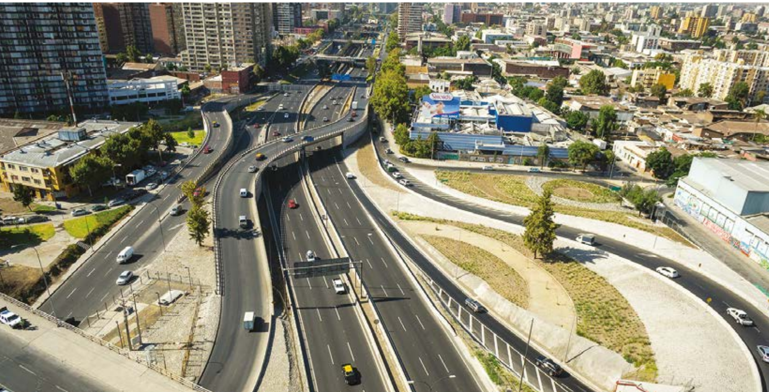
Víaschile. Autopista Central
