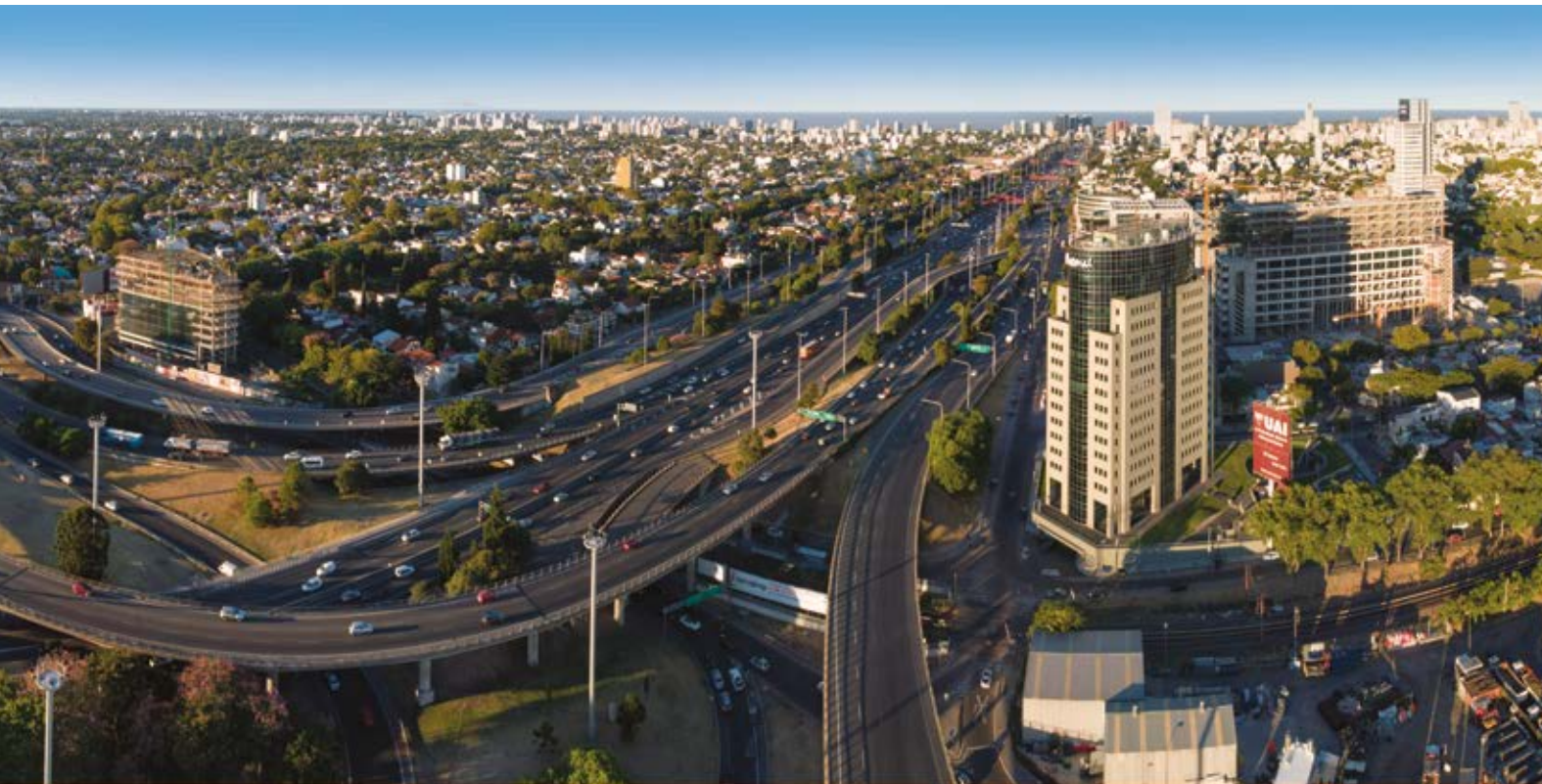
Autopistas del Sol. Argentina
