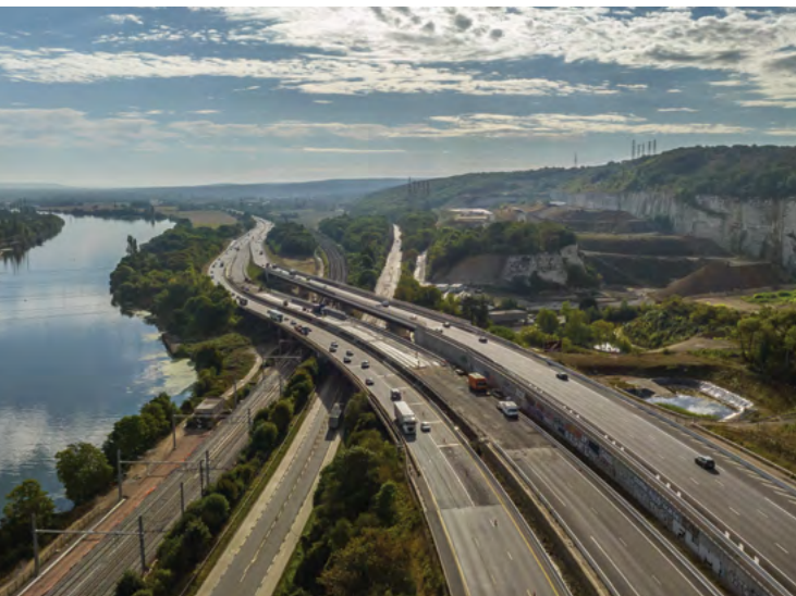
A-13, Viaduc de Guerville, France.
